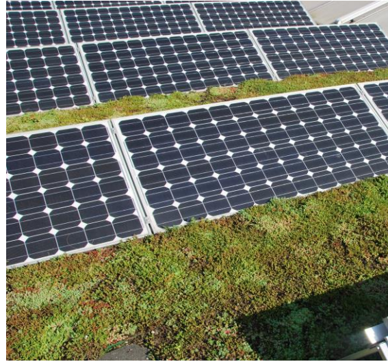
Groene daken en zonnepanelen
